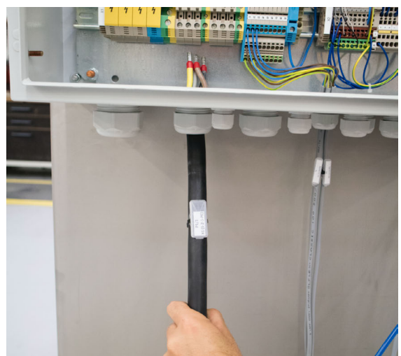
Kabel in Regelung führen.
