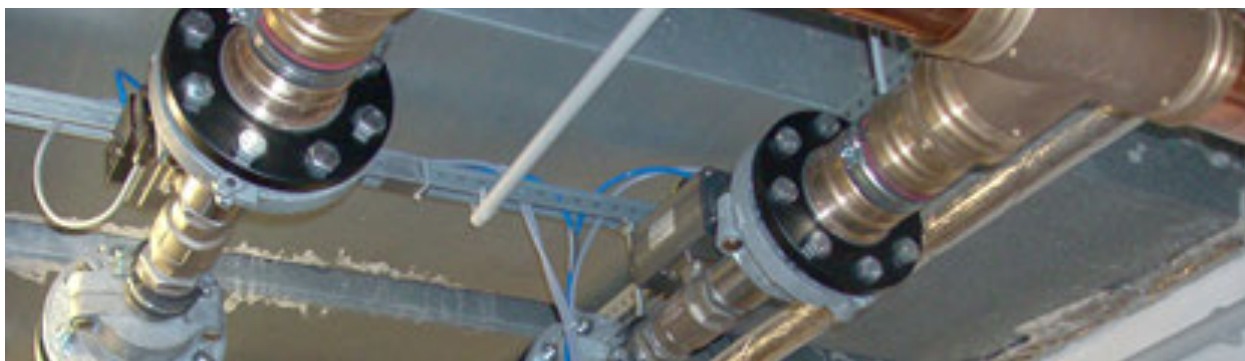
Beispielhafte Anbindung PNE an Entwässerungsinstallation.
