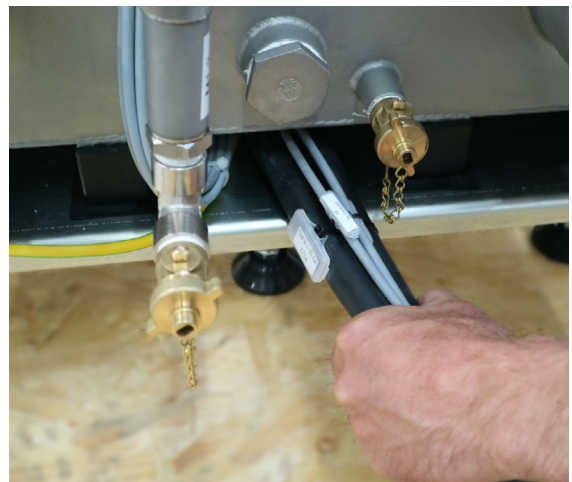
Kabelstrang mittig unter Behälter führen.
