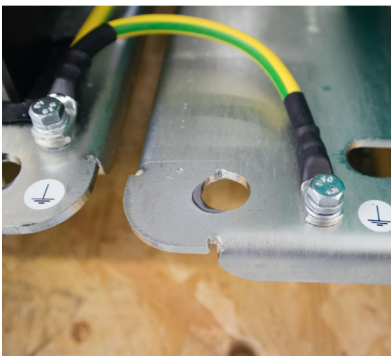
Montierte Erdung.
