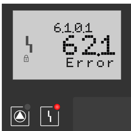
Beispiel: Codierung 62.1, Fehler TW-Armaturentest
