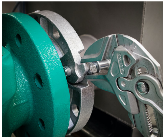
Klappflansch Öffnung drehen zum Fixieren.
