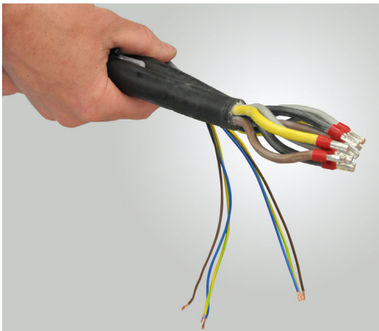
Kabelstrang vom Pumpensegment.
