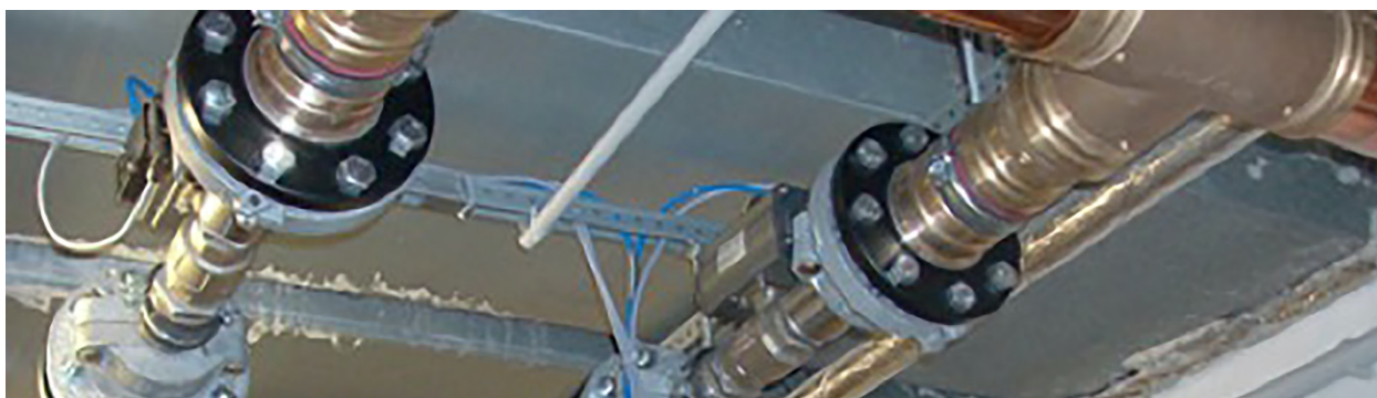
Beispielhafte Anbindung Pumpen–Notentwässerung an Entwässerungsinstallation.
