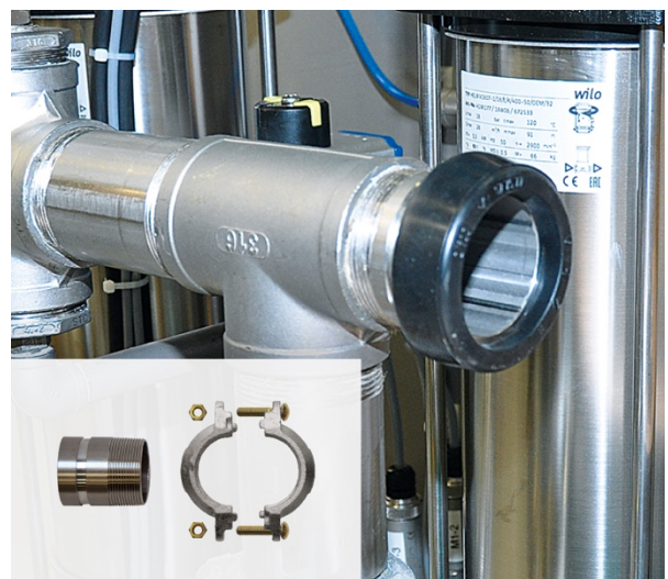
2. Vorgefetteten Dichtungsring aufstecken.
