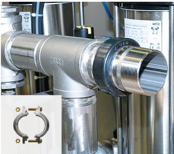
3. Übergangsstück einfügen.
