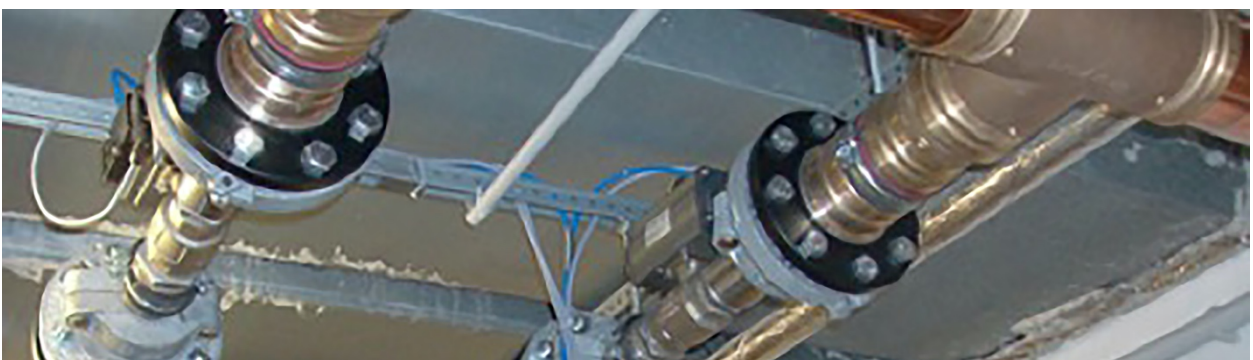
Beispielhafte Anbindung Pumpen-Notentwässerung an Entwässerungsinstallation.
