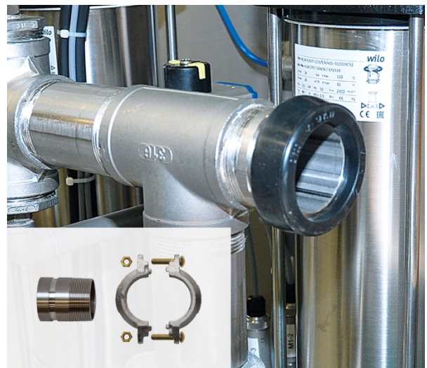
2. Vorgefetteten Dichtungsring aufstecken.
