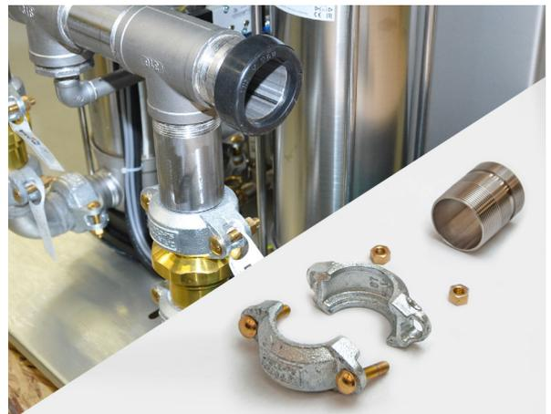
2. Vorgefetteten Dichtungsring aufstecken.
