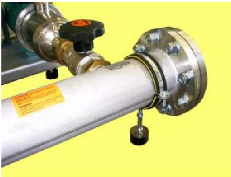
**Рисунок 10. Закрепление коллектора при помощи опоры с амортизатором**
