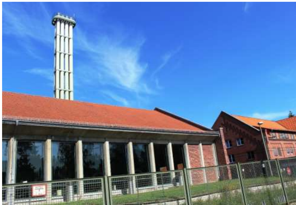
Wasserwerk Beelitzhof, Kronprinzessinnenweg 23; 14129 Berlin (Wannsee)
