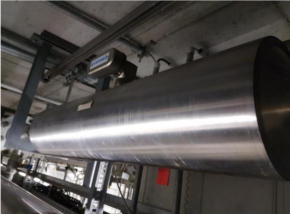
OPTIMASS eingebaut in einer Leitung
