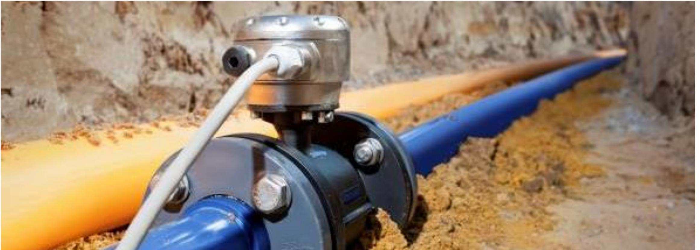
Trinkwasserleitung – Messung um Rohrleitungsnetz zu überwachen und Leckagen zu erkennen
