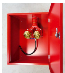
Abb. 1 (li.): Löschwassereinspeisung ohne Schrank, mit Anschluss unten
