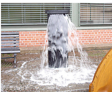
Auslaufbauwerk auf Gehweg, Achtung! Gefahr der Eisbildung
