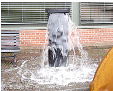
Auslaufbauwerk auf Gehweg, Achtung! Gefahr der Eisbildung
