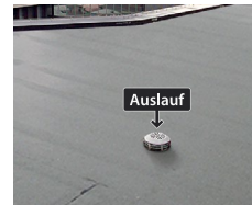
Integration im Dach – Ableitung auf Dach.
