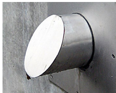
Integration in Fassade – Ableitung auf Anlieferfläche.
