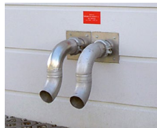
Integration in Fassade – Ableitung auf Verkehrsfläche.
