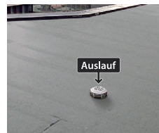
Integration im Dach – Ableitung auf Dach.
