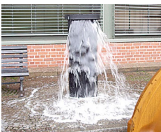
Auslaufbauwerk auf Gehweg, Achtung! Gefahr der Eisbildung
