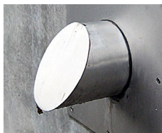
Integration in Fassade – Ableitung auf Anlieferfläche.
