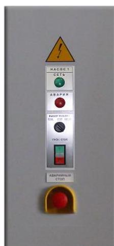
Рис. 7. Выносной пульт ручного управления насосом.
