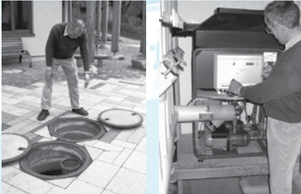
Люки резервуара та фільтра шахтного типу «ліворуч», та технічна кімната з насосною станцією (праворуч)
