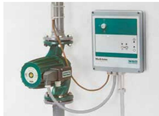
Wilos erste stufenlose elektronische Drehzahlregelung für 3-Phasen-Nassläufermotoren wurde bereits von einem Mikroprozessor gesteuert. Mithilfe der neuen Technologie konnte für eine Drehzahlreduzierung von 30 bis 40 Prozent gesorgt werden.
