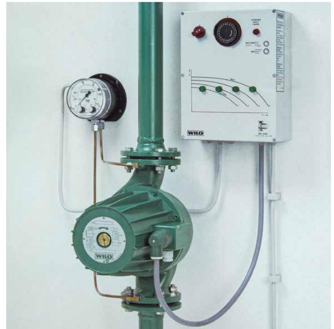
Drehzahlumschaltung mit 4-Stufen-Schaltgerät für 3-Phasen-Nassläufermotoren, automatisch gesteuert mittels Zeitschaltuhr, z.B. für die Nachtabsenkung oder die Anpassung an den Wärmebedarf.
