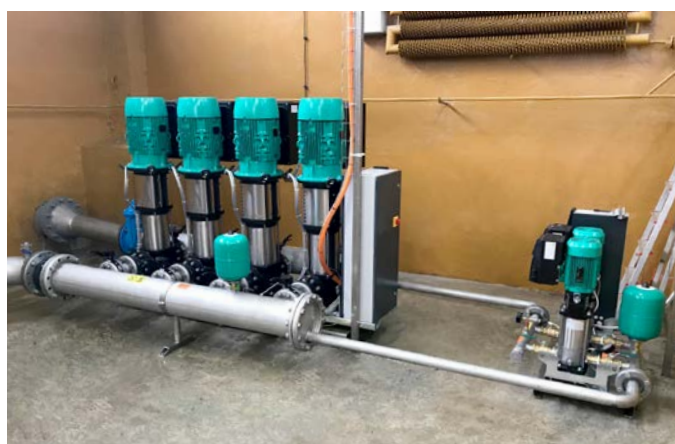
Stan po modernizacji
