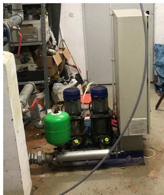
Stan przed modernizacją
