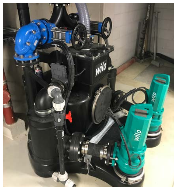
Stan po modernizacji
