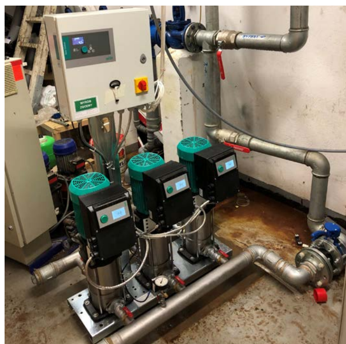
Stan po modernizacji
